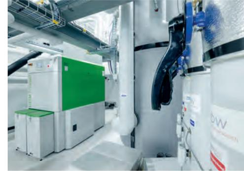
Im Gebiet Turmstrasse wurde der dritte Wärmeverbund der ibw in Betrieb genommen. Die Heizzentrale mit Pelletheizung und Gaskessel für Spitzenzeiten versorgt über 100 Wohnungen in 15 Mehrfamilienhäusern zuverlässig mit Wärme für Heizung und Warmwasser.
